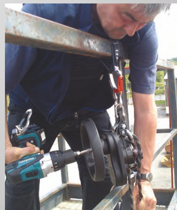
Levage à travers la perceuse
